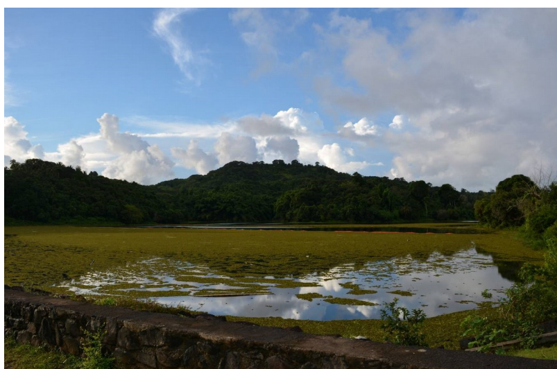
Figure 13 : Retenue collinaire de Combani.
